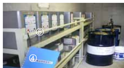
〔危険物倉庫(内部)〕
